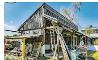
Der alte Pferdestall zu Beginn der Umbauarbeiten.
